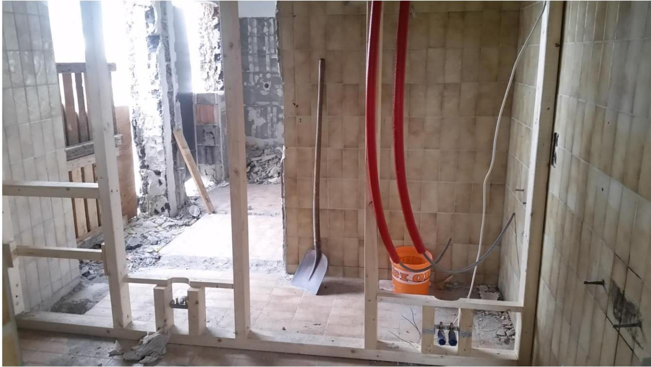
In den WC`s wurden schnell Zwischenwände eingebaut, damit Guido die Vorinstallation machen konnte.
