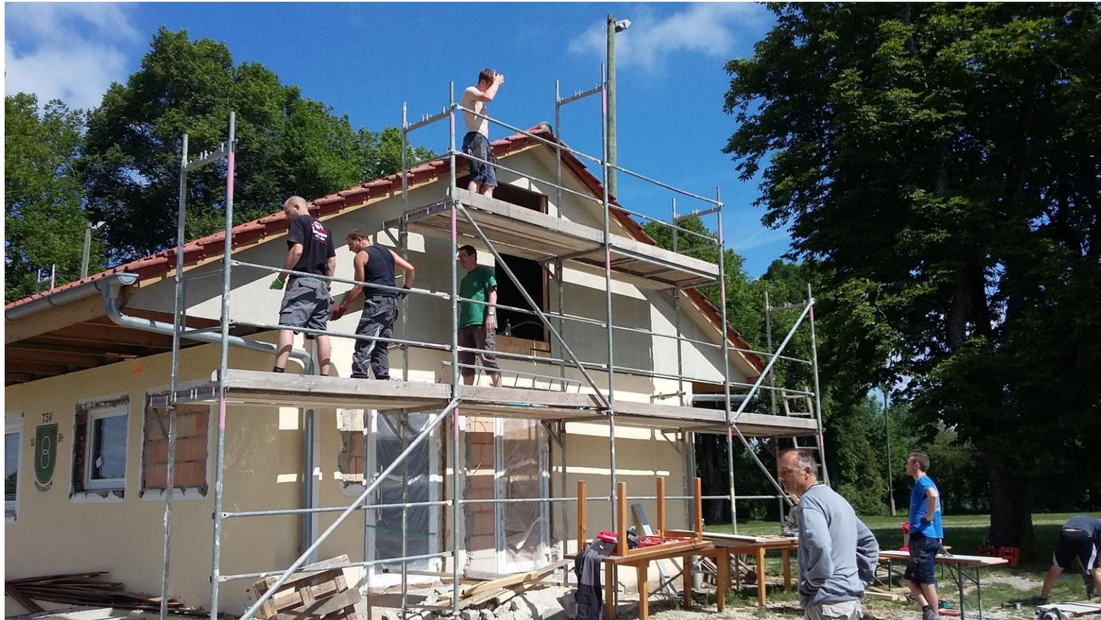
Die Decke vom Dachvorsprung wurde auch entfernt und die Risse im Putz repariert.
