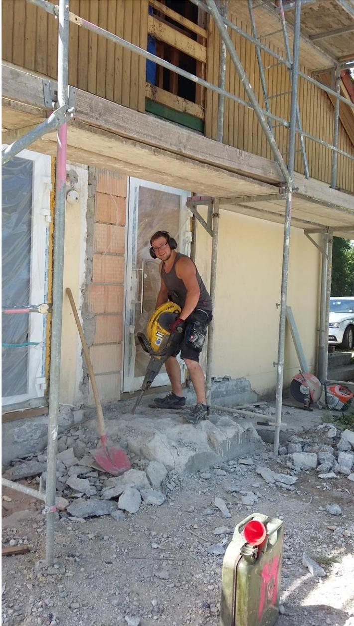
Auch Außen sollte sich noch einiges tun. Da die Nut- und Federbretter in die Jahre gekommen waren, wurde die komplette Fassadenrenovierung beschlossen. Um später die Wand zum See verputzen zu können, musste auch ein Teil der alten Betonstufen entfernt werden!
