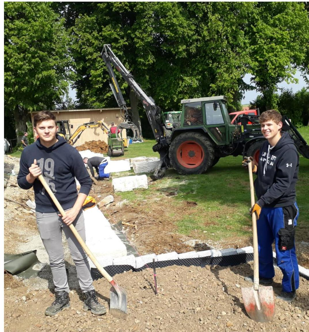
Die Kalksteine wurden von Fäde's Greifer gesetzt und anschließend von Hand nachjustiert.
